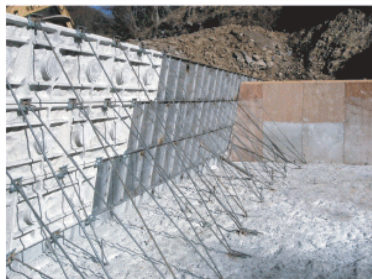
本堤表面・PC-Ⅲ型(ワリイシ)/残存メッシュ型枠 併用据付状況
