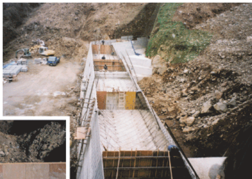
本堤・コンクリート打設/コンクリート打継ぎ状況
