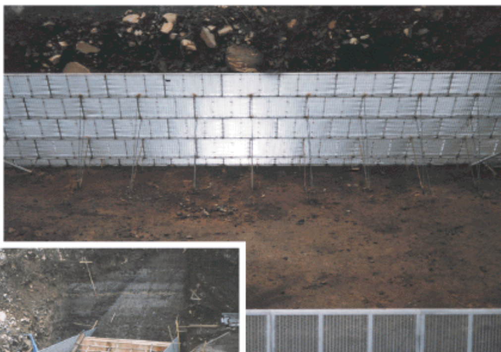
本堤下部・残存メッシュ型枠(表/裏)据付状況
