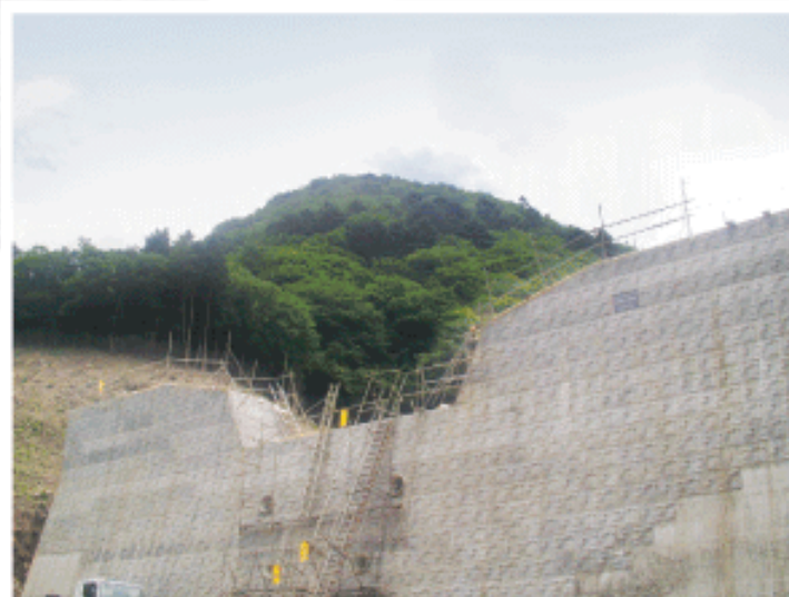
本提全景・PC-Ⅲ型(ワリシ)／残存メッシュ型枠
