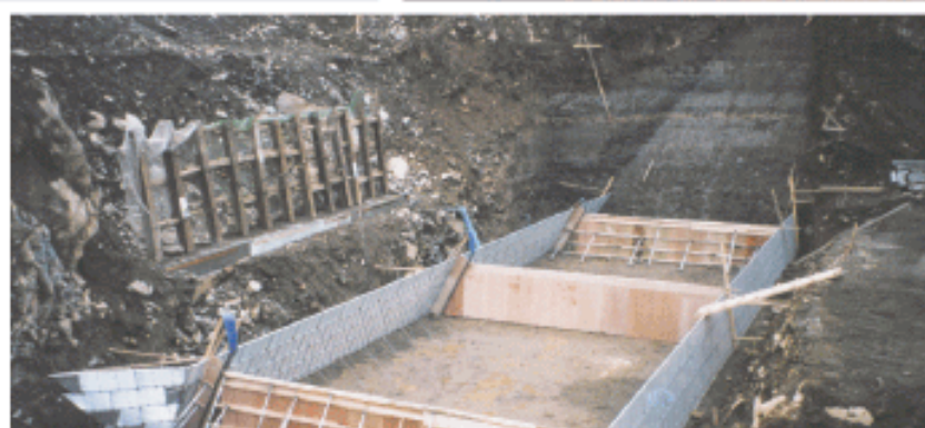
本堤下部・残存メッシュ型枠(表/裏)据付状況
