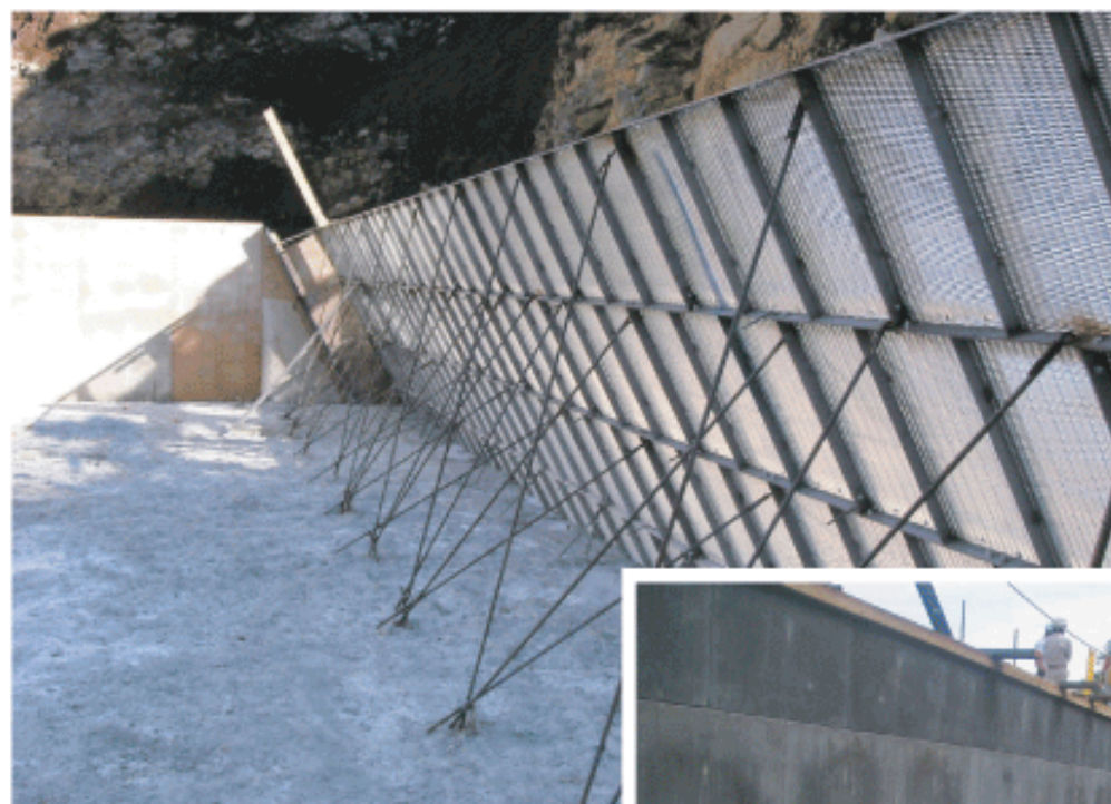
本提裏面・残存メッシュ型枠据付状況
