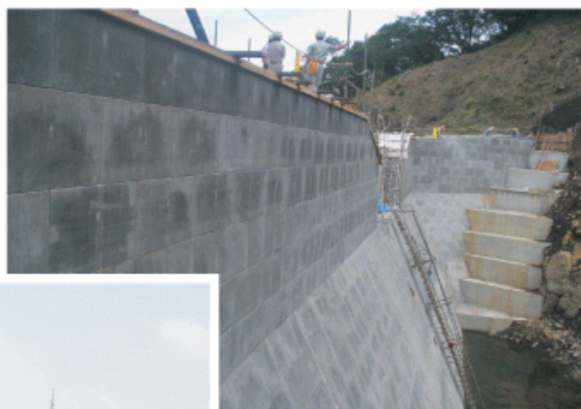
本提裏面・PC-Ⅲ型(フラット)／残存メッシュ型枠
