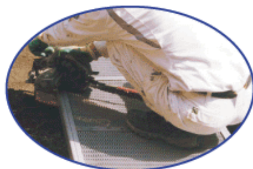
「残存メッシュ型枠」 の切断加工は容易です。
