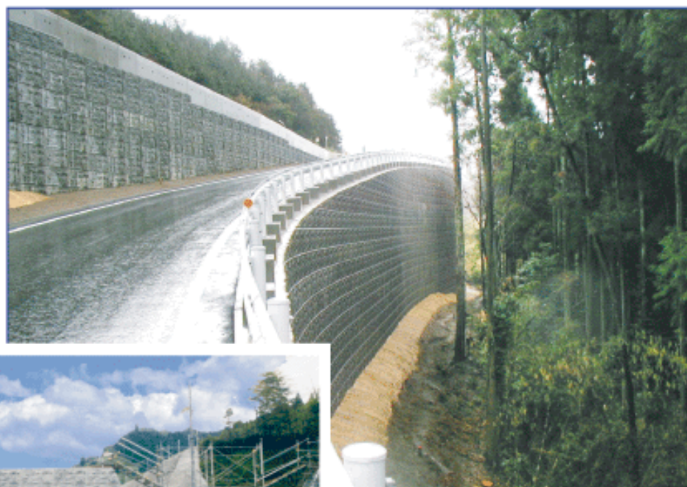
大分県：大分387号椎屋地区道路新設工事
