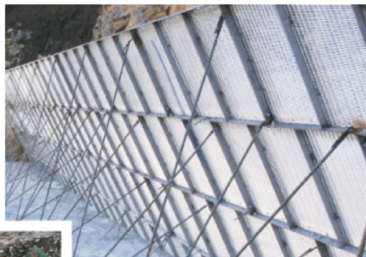
本堤裏面:残存メッシュ型枠据付
