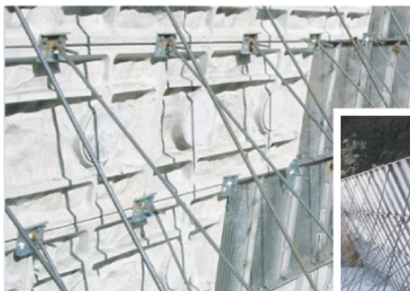
本堤表面:PC-Ⅲ型(ワリシ)/残存メッシュ型枠 併用据付
