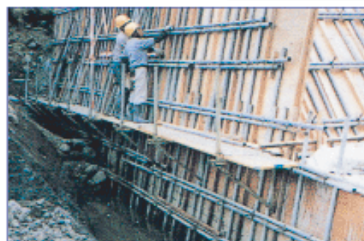
② 従来工法(合板型枠の仮設)
