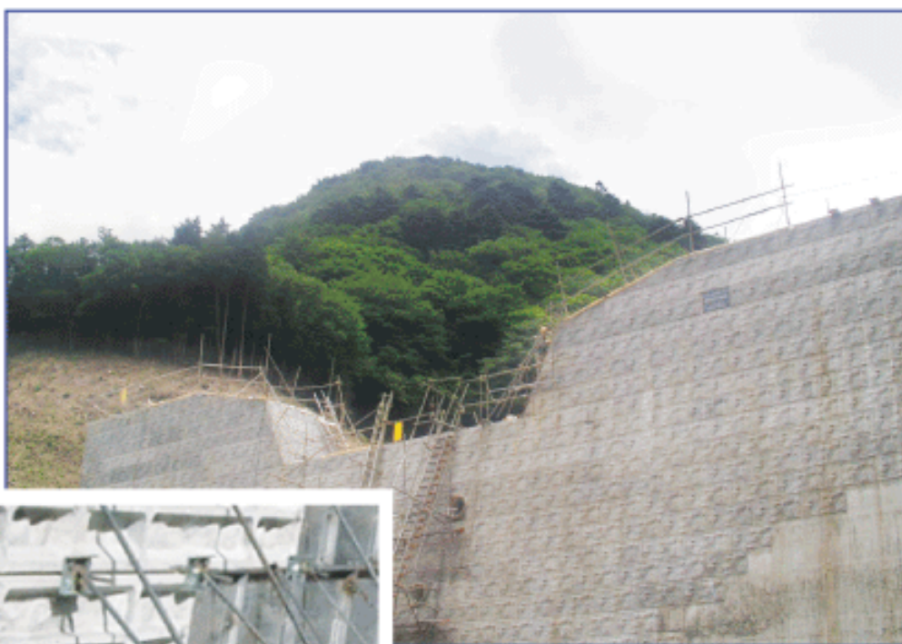
本堤全景:PC-Ⅲ型(ワリシ)/残存メッシュ型枠
