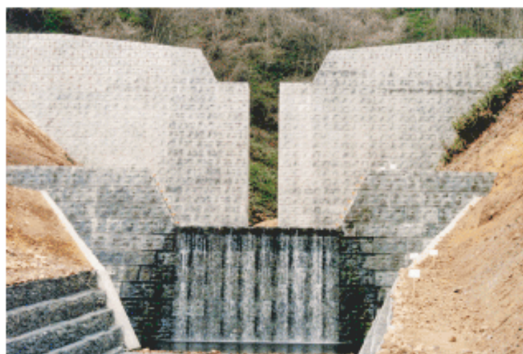
岩手県：滝ノ沢筋滝ノ沢砂防工事
