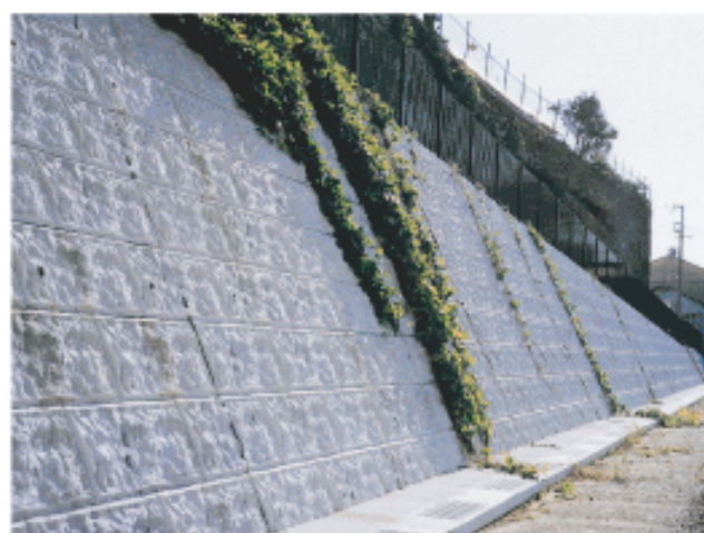
兵庫県：名倉小学校敷地整備工事
