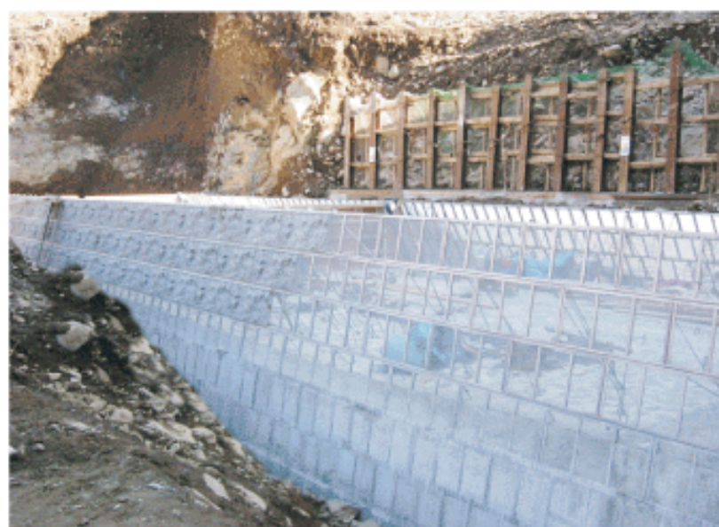
本堤表面:PC-Ⅲ型(ワリシ)/残存メッシュ型枠据付
